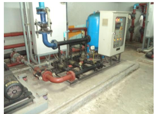
ผ 3-18 ถังเก็บน้ำที่ผ่านการบำบัดเพื่อนำกลับไปใช้รดน้ำต้นไม้และระบบปั๊มน้ำของโครงการ
