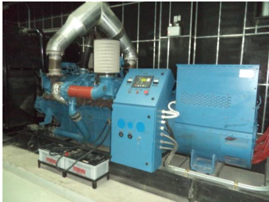
ผ 3-35 เครื่องปั่นไฟฟ้าสำรองและชุดไปสำรองฉุกเฉินของโครงการ
