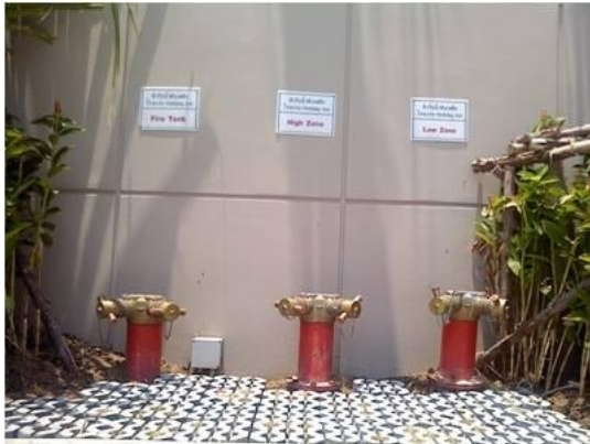
ผ 3-38 ติดตั้งหัวรับน้ำดับเพลิงภายนอกอาคารชนิดข้อต่อสวมเร็วและจัดให้มีถังน้ำสำรองเพื่อการดับเพลิงได้ดิน
