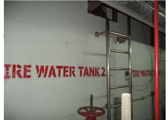
ผ 3-38 ติดตั้งหัวรับน้ำดับเพลิงภายนอกอาคารชนิดข้อต่อสวมเร็วและจัดให้มีถังน้ำสำรองเพื่อการดับเพลิงได้ดิน
