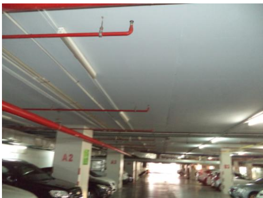
ผ 3-40 ระบบดับเพลิงอัตโนมัติ (Sprinkler System)
