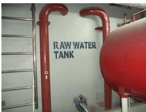
ผ 3-19 บริเวณถังเก็บน้ำดิบสำรองชั้นใต้ดินและระบบปั๊มน้ำดิบของโครงการ
